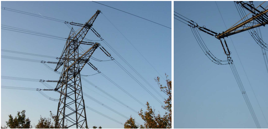
Abbildung 5.3.2.: Hochspannungsleitungen mit zusammengesetzten „Drähten“, bei denen mehrere leitend miteinander verbundene Einzeldrähte über Abstandhalter einen großen „Draht“ bilden, um die Feldstärke zu reduzieren.
