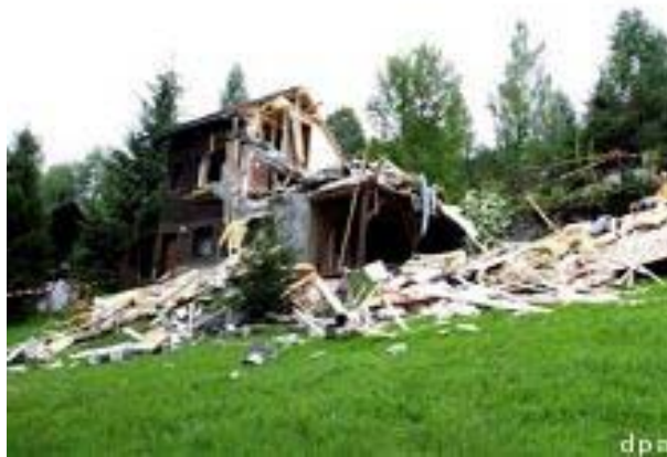
Abbildung 3.4.2.: Schäden durch eine Dampfexplosion. 8
